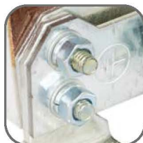
Болты с повышенным классом прочности
